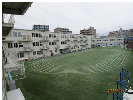
東中仮設校舎
